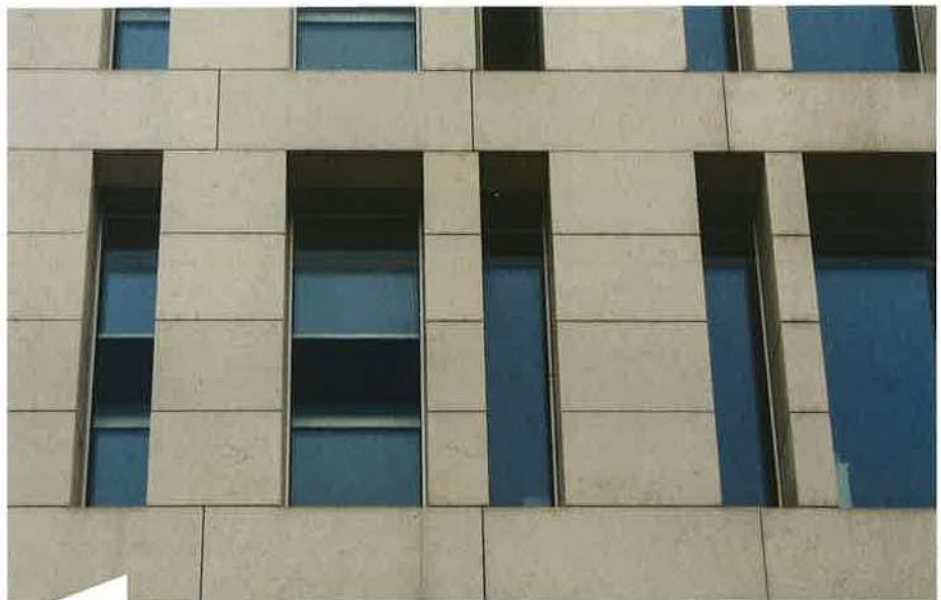
Unschön ist bei der DIN 18008-2, dass das Problem „handtuchformatiger“ 3-fach-Isoliergläser ab ca. 0,85 m kurzer Kantenlänge beginnt. Ein großer Teil dieser ISO lässt sich unter Norm-Randbedingungen nicht mehr nachweisen. Hier sind ortshöhenindividuelle Bemessungen oder vorgespannte Glasarten erforderlich.
